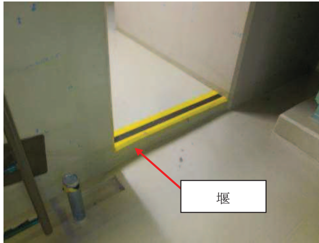
図 4-1 漏えい油の拡大防止対策の例
