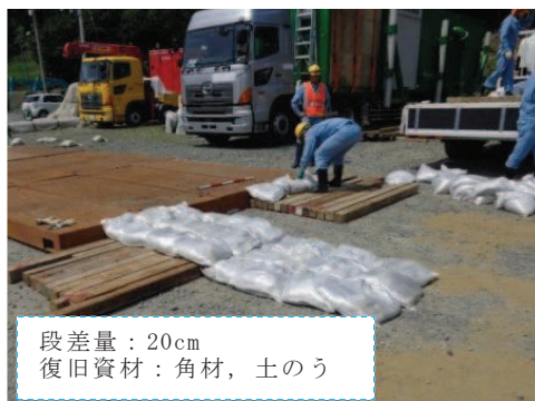
段差復旧作業状況
