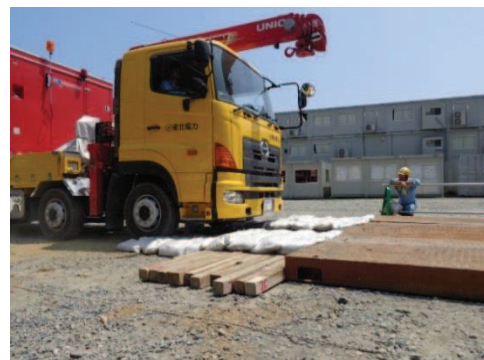
大型車両通行状況
