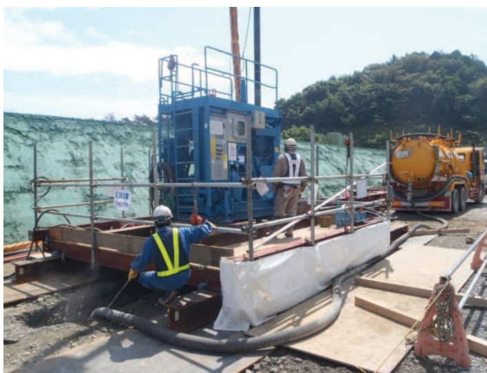
図 6.4-3 施工状況写真
