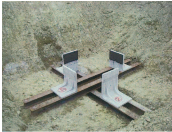
図 6.4-16 L字擁壁設置状況
