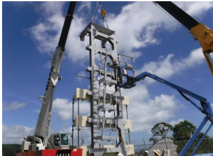
写真 10.4-2 吊治具の立起こし状況
