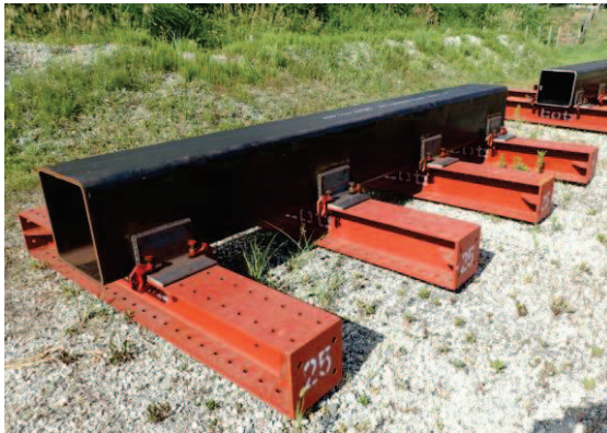
写真1 模擬建屋構造材設置
