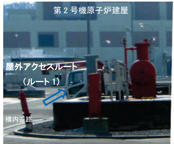
写真 C:地震後の状況【平成 23 年 3 月 12 日撮影】
