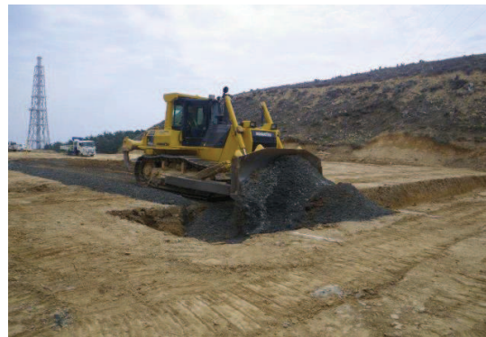
写真2 碎石運搬・埋め戻し・転圧状況
