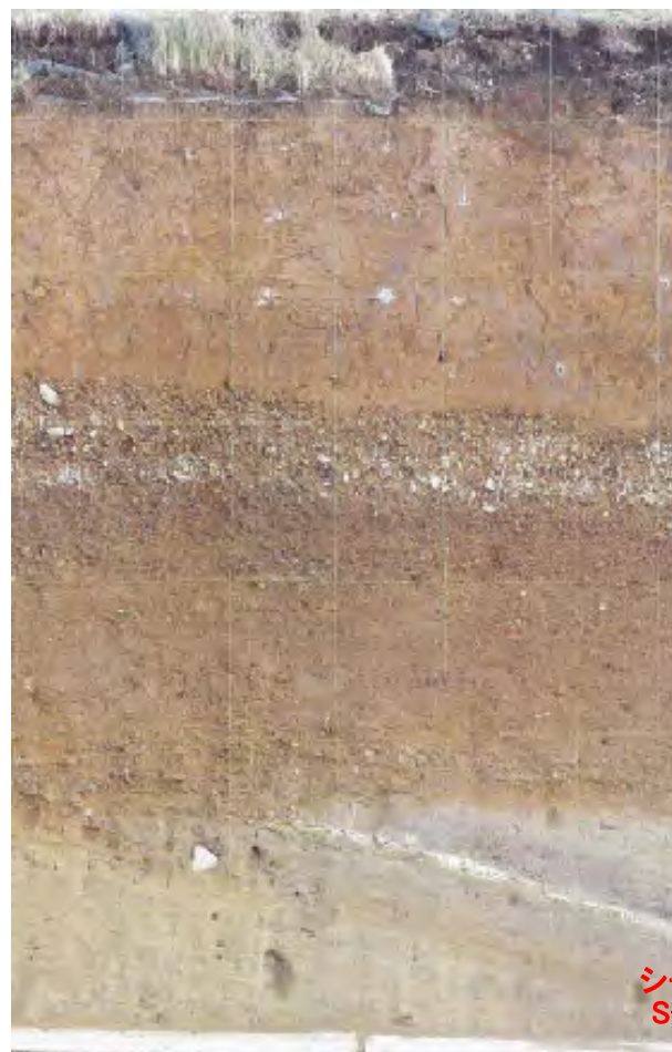
Ts-5法面画像
