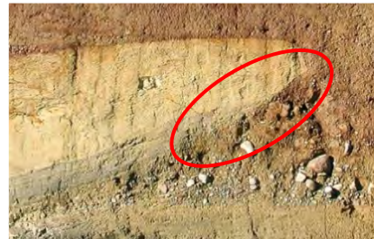
③ 3.5m西方法面
