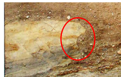
⑩ 14m西方法面
