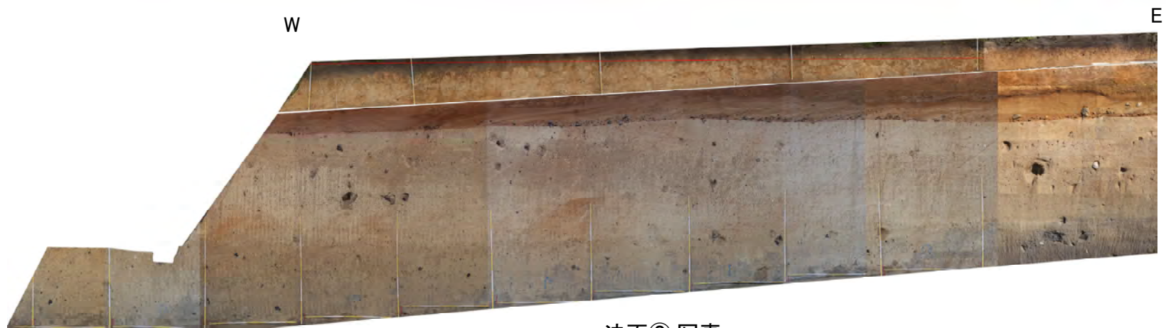
法面② 写真
