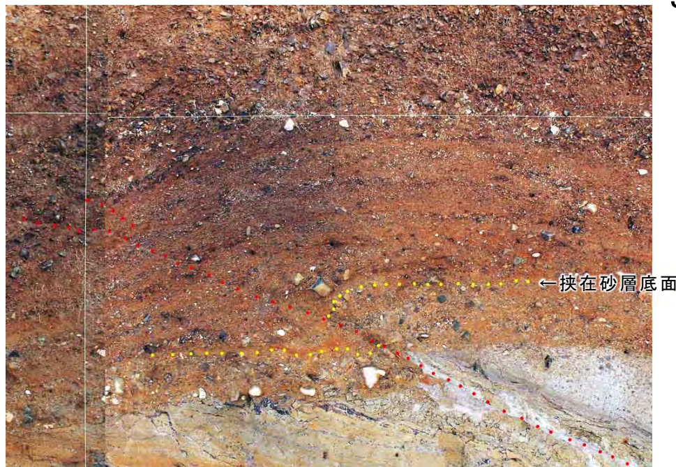
Ts-6法面詳細写真 0 1m
