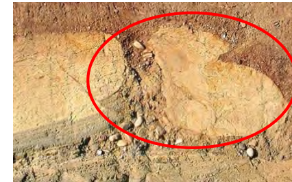
④ 5m西方法面
