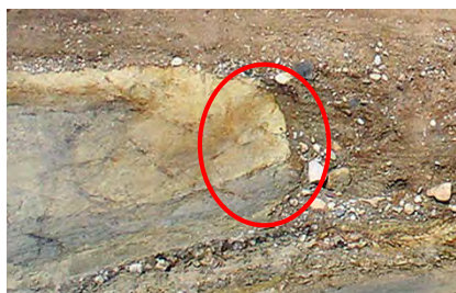
⑨ 12.5m西方法面
