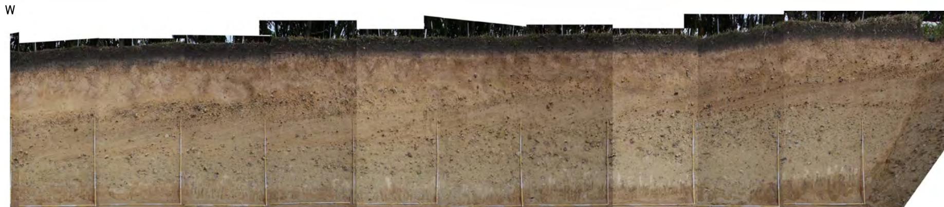
法面③ 写真
