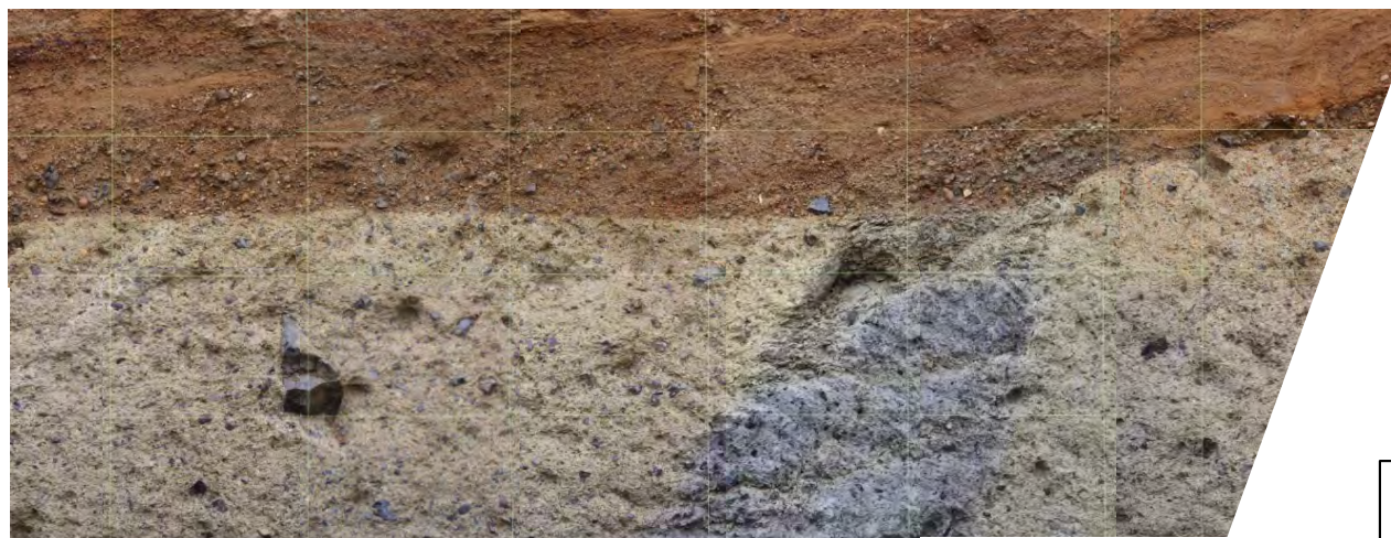
北側法面写真
