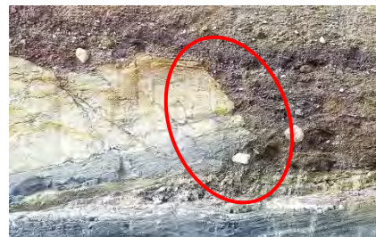
⑥ 8m西方法面
