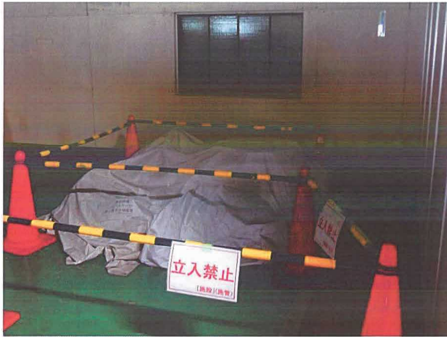
図3 廃材保管状況
