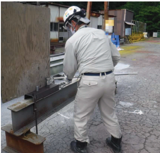
M30 締付状況 (壁際) 締付状況写真 (トルクレンチ使用時)
