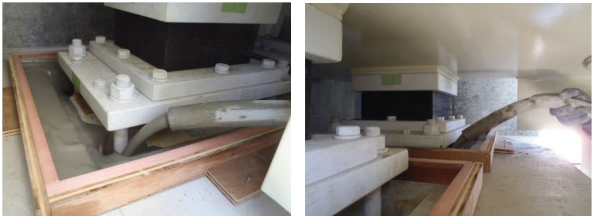
(無収縮モルタル施工状況の例)
