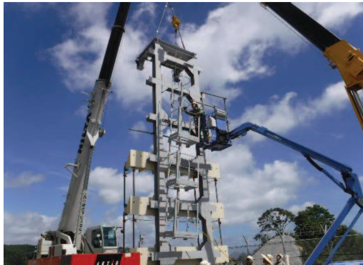
写真 10.4-2 吊治具の立起こし状況
