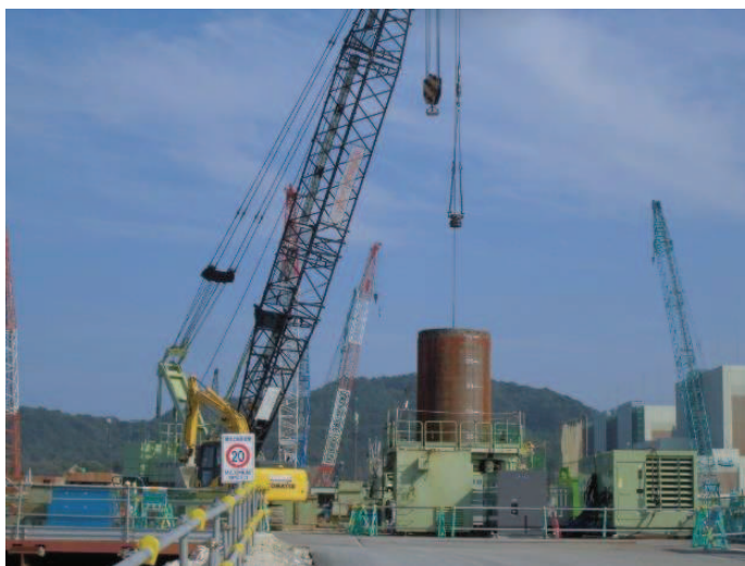
図 13.3-1 防潮堤（鋼管式鉛直壁）の鋼管杭施工写真
