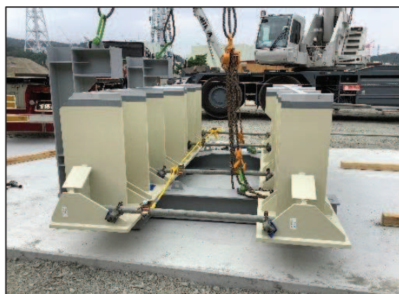
吊治具と架台の固定状況（最上段）
