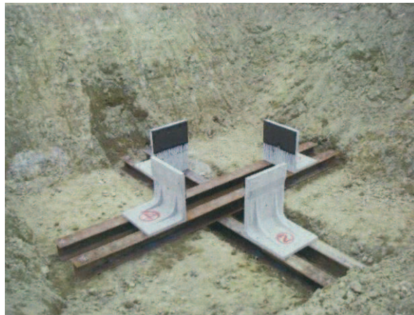
図 6.4-16 L字擁壁設置状況
