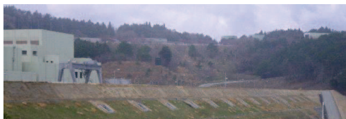
既設防潮堤完成状況 (平成24年4月26日)
