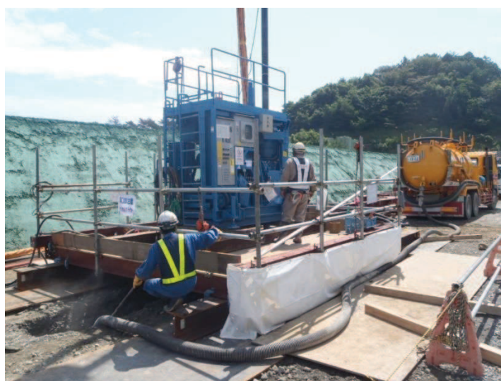
図 6.4-3 施工状況写真
