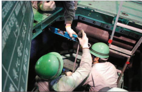
伸び変形量 (枠間距離) 計測状況 (計測値 720mm - 初期値 370 mm* = 伸び 350mm)
