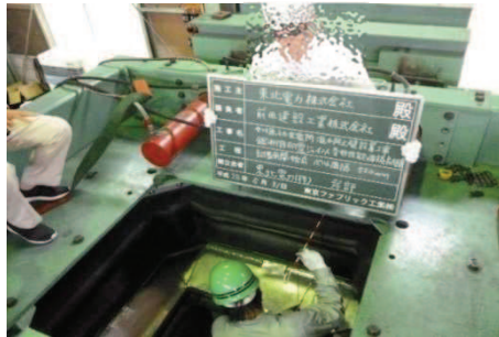
枠間距離計測状況
