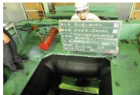
加圧完了 (0.15 MPa, 1 時間保持後, 漏水なし)
