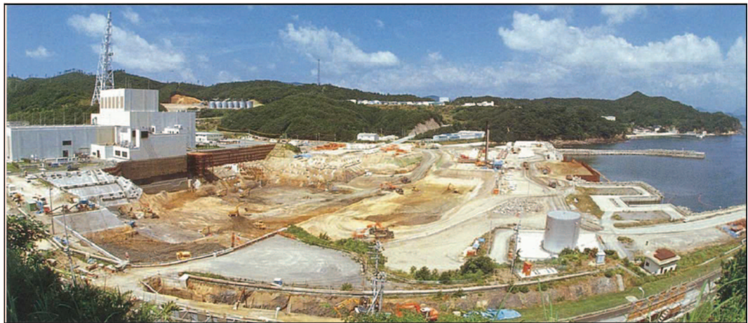
図 3-5 第 2 号機建設時の掘削状況
