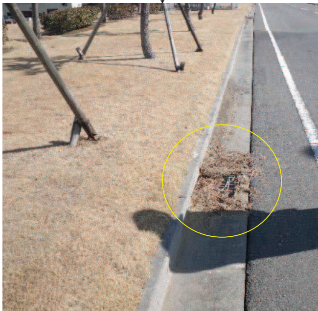
写真2 構内道路上に残留した塵芥
