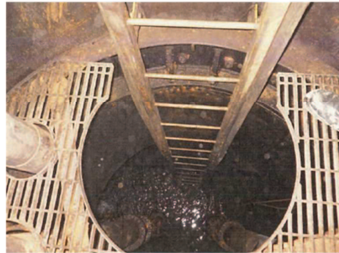
写真C 揚水井戸⑦(下段部) 2017/3/16撮影
