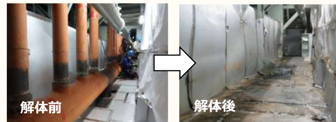
蒸気ヘッド⇒2021年度解体実施
