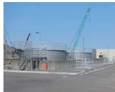
改造前 (半地下構造物)
