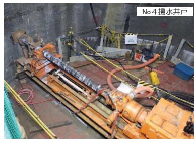
ドレーン(鋼管)削孔状況
