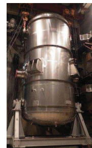
フィルタ装置(C)据付作業状況
