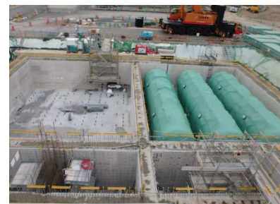
改造後 (地下構造物, タンク設置時)
