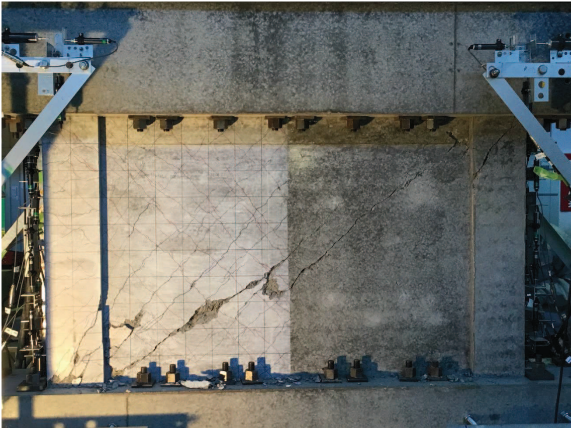
図 2-6 試験体 S-06-D0 最終破壊時写真
