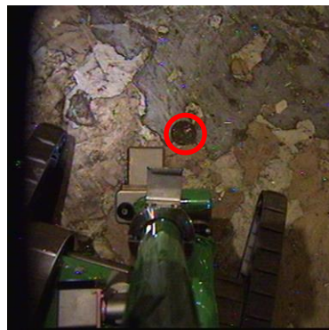
部拡大現場状況
