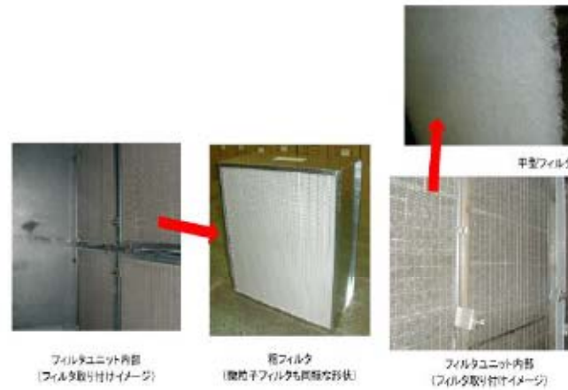
図-5 換気空調設備のフィルタ設置状況
