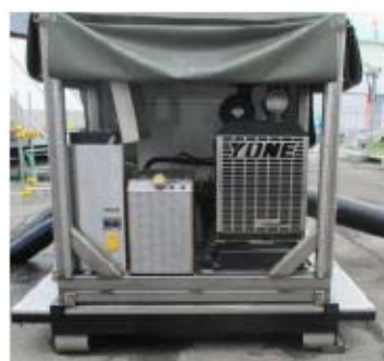
泡混合設備設置
