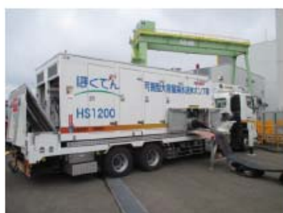
可搬型大容量海水送水ポンプ車の設置
