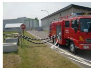
水源への吸管挿入 (屋外 T. P. 10. 3m)
