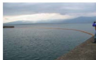
間口部シルトフェンス 設置状況
