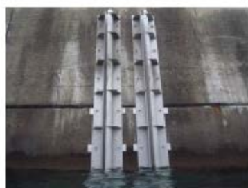
荷揚場シルトフェンス固定金具
