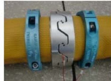
可搬型ホース (150A) 接続後
