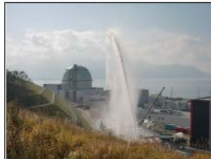
第2図 直状放射による放水状況
