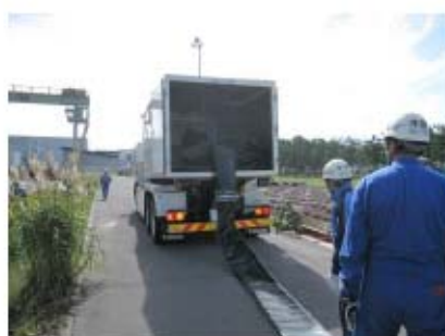
ホース延長・回収車による 可搬型ホース敷設
