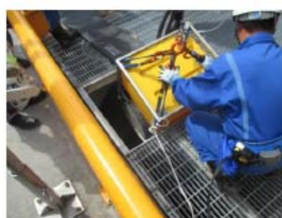
海水取水箇所への水中ポンプ設置
