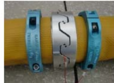
可搬型ホース(150A)接続後
