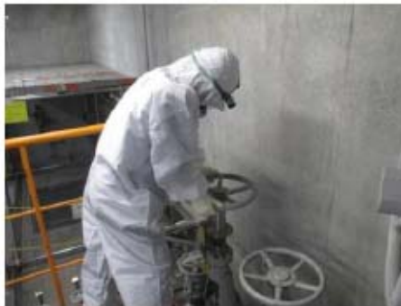
補助給水ピット水源切替 系統構成 (原子炉建屋 T. P. 24. 8m)
