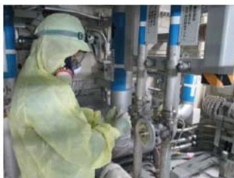
燃料取替用水ピット 補給ライン系統構成 (原子炉補助建屋 T.P. 10. 3m)
