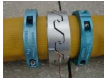
可搬型ホース(150A)接続後
