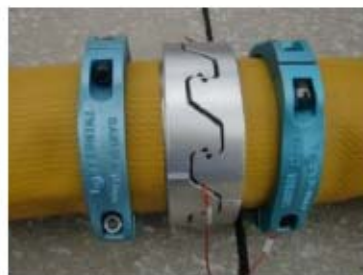
可搬型ホース(150A)接続後
