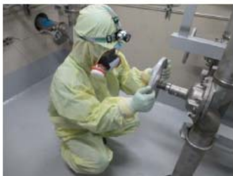
1次系補給水ポンプによる 補給系統構成 (原子炉補助建屋 T.P. 17.8m)
