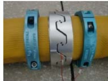
可搬型ホース (150A) 接続後
