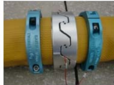
可搬型ホース (150A) 接続後
