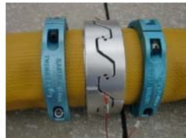
可搬型ホース (150A) 接続後
