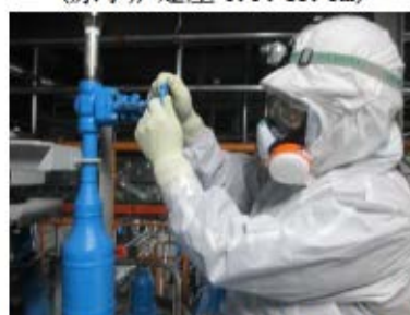
原子炉補機冷却水系統加圧操作 (原子炉建屋 T. P. 46. 2m)
