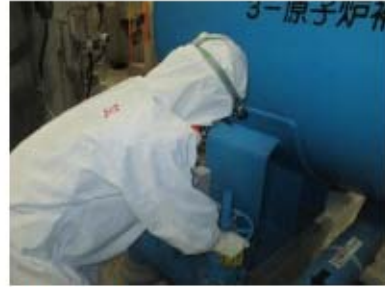
補機冷却水（海水）通水系統構成 （運転員（現場）②） （原子炉建屋 T. P. 43. 6m）
