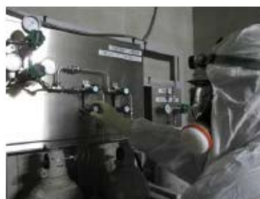
原子炉補機冷却水系統加圧 系統構成 (原子炉建屋 T. P. 43. 6m)
