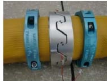
可搬型ホース (150A) 接続後
