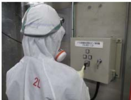
SG直接給水用高圧ポンプ起動操作 （原子炉建屋 T.P. 24. 8m）
