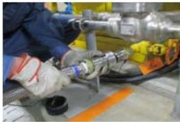
ホース接続操作 (油タンク側) (タービン動補助給水ポンプ室 T.P. 10.3m)
