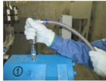
ホース接続操作 (軸受側) (タービン動補助給水ポンプ室 T.P. 10.3m)
