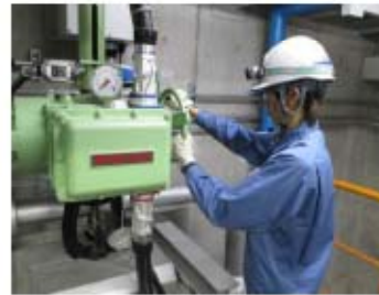
タービン動補助給水ポンプ 駆動蒸気入口弁「開」操作 (タービン動補助給水ポンプ室 T.P. 14.3m)
