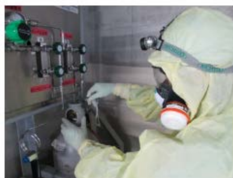
加圧器逃がし弁 代替制御用空気供給操作 (原子炉建屋 T. P. 17. 8m)
