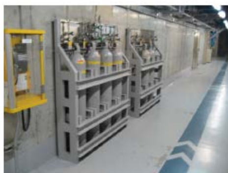
主蒸気逃がし弁操作 可搬型空気ポンベ (原子炉建屋 T. P. 10. 3m)
