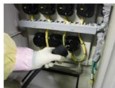
電源ケーブル接続 (原子炉建屋 T.P. 24. 8m)
