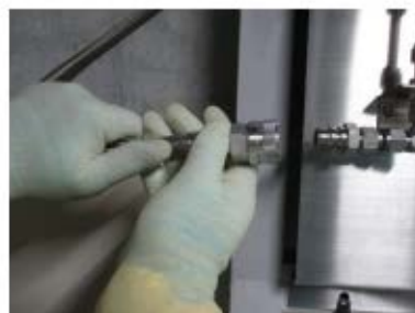
アニュラス全量排気弁操作用可搬型 窒素ガスポンベのカップラ接続 (原子炉補助建屋 T.P. 40.3m)
