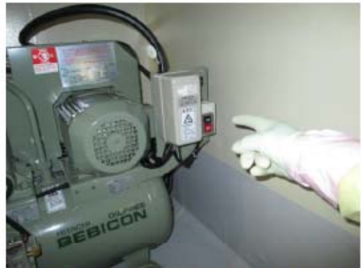
可搬型代替ガスポンプ リング 圧縮装置起動 (原子炉建屋 T.P. 24.8m)
