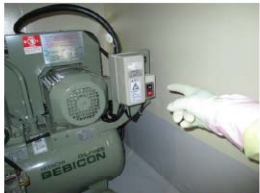
可搬型代替ガスシリンダリック圧縮装置起動 (原子炉建屋 T.P. 24.8m)
