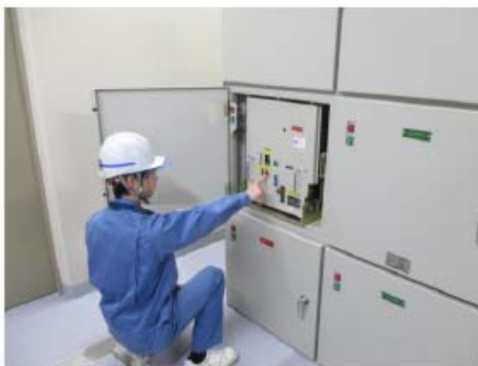
原子炉トリップ遮断器現場開放操作 (原子炉建屋 T.P. 17.8m)
