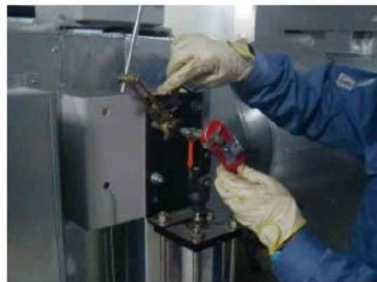
(空気作動ダンパ開作業イメージ)
