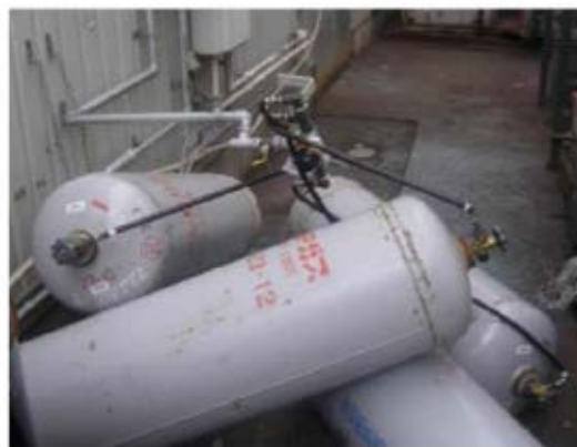
東日本大震災でのLPガスボンベ 流されたの被災状況の一例 3)
