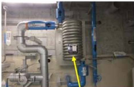
格納容器雰囲気ガスサンプル冷却器
