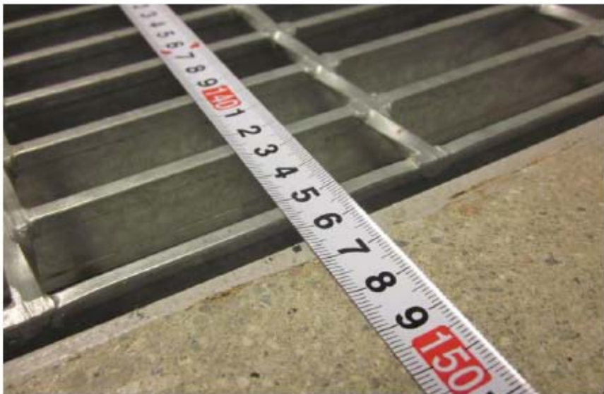
参考資料 1 添付 2-図 4 主蒸気管室 T. P. 29.3m 床面開口部写真
