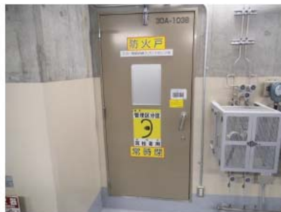
(6) A-格納容器スプレイポンプ室扉
