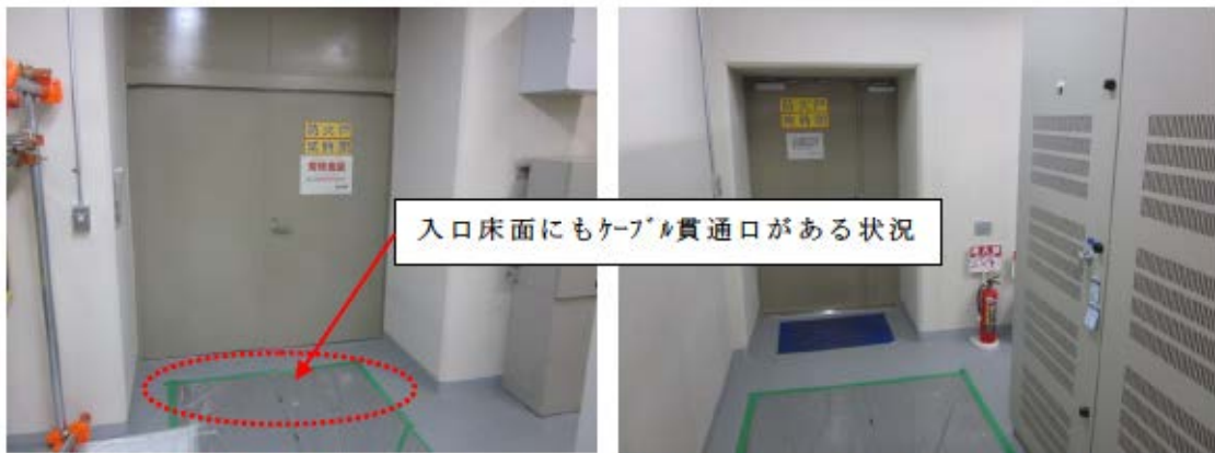
参考資料 1 添付 2-図 3 安全系計装盤室の 2 箇所の入口扉の状況
