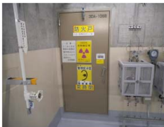
(9) B-余熱除去ポンプ室扉
