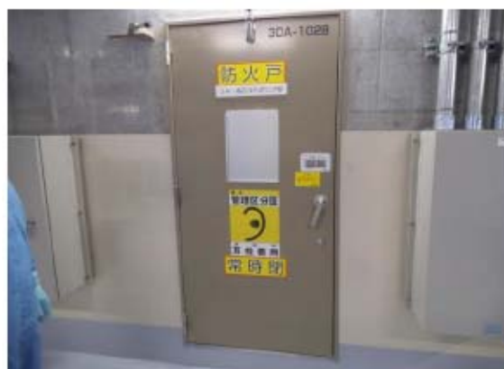
(4) A-高圧注入ポンプ室扉
