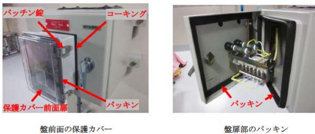
図1 被水防護対策の写真（例）
