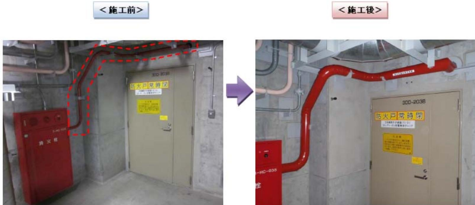
被水源である消防配管（ピンホールを想定）に対して、飛散防止のための板金保温を配管外表面に取り付ける
