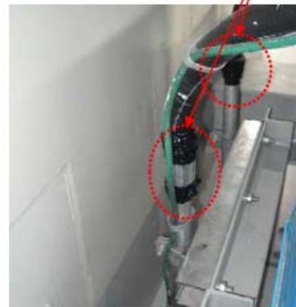
防護対象設備のうち電動弁のケーブル接続部に対してシリコンシーラントによるシール施工を実施
