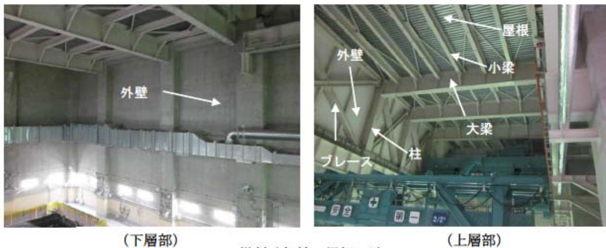
燃料取扱棟の屋根、壁
