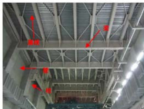
燃料取扱棟の屋根、梁、柱、壁
