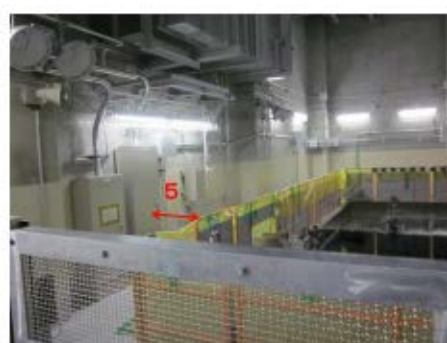
使用済燃料ピットとフェンス、手摺りの距離
