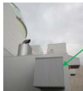
建屋開口部B (屋外から撮影)
