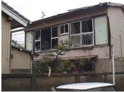
激しく損壊してしまった民家
