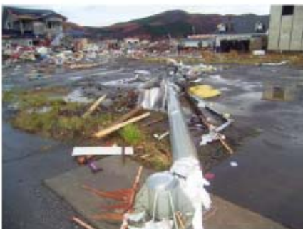
道路標識の折損
