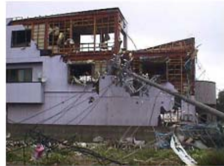
電柱の倒壊と竜巻によって激しく損壊された民家
