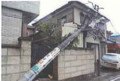
電柱の折損・傾斜
