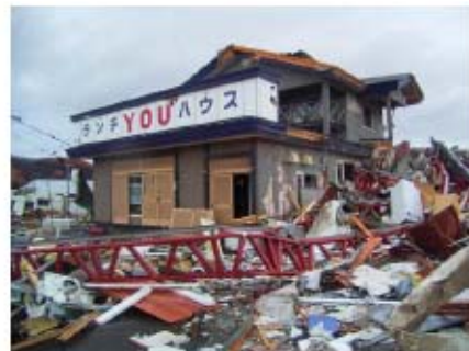
飛来物による損傷の激しい店舗併用住宅
