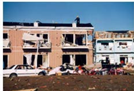
竜巻被害状況(損傷した建物)
