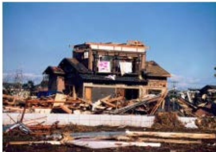
竜巻被害状況(損傷した建物)
