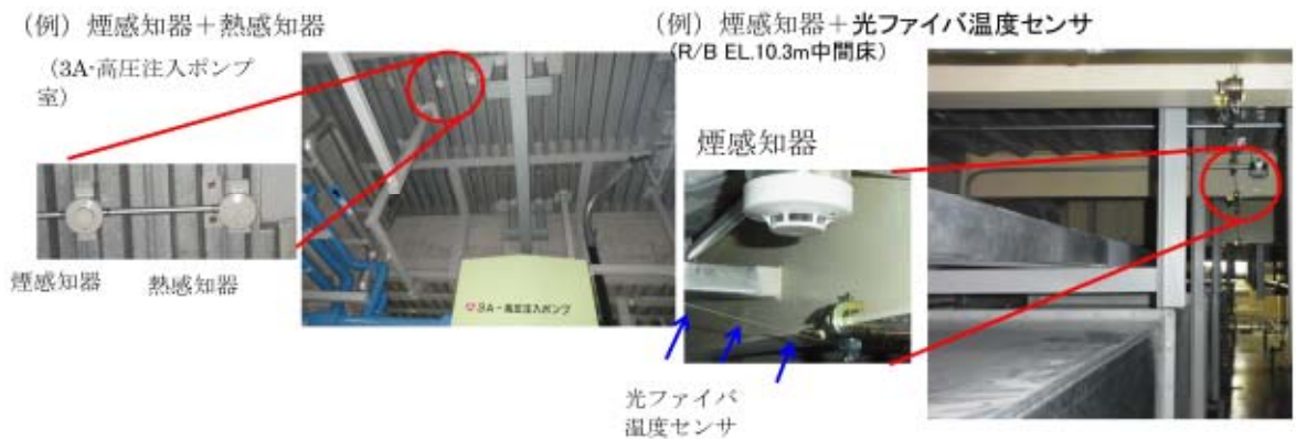
図-9 煙感知器、熱感知器、光ファイバ温度センサ設置例
