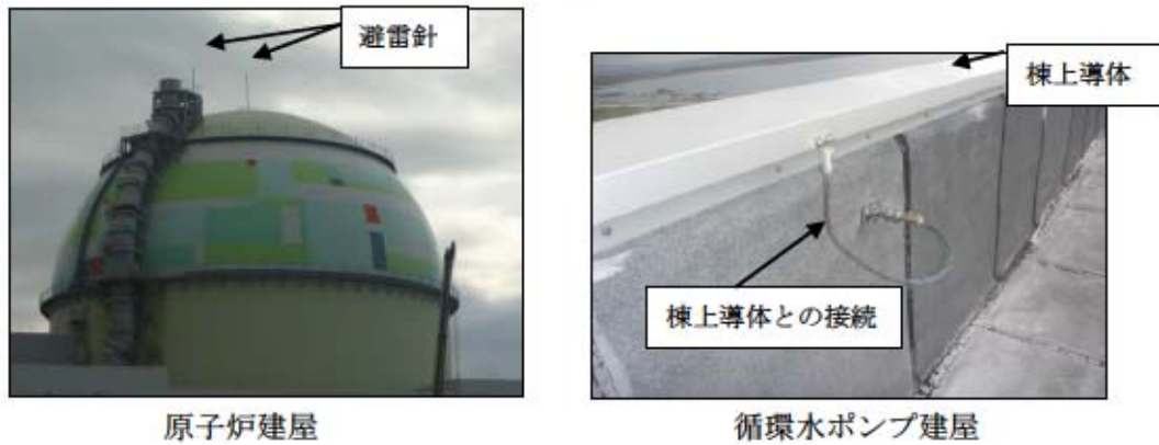
図-6 避雷設備設置例
