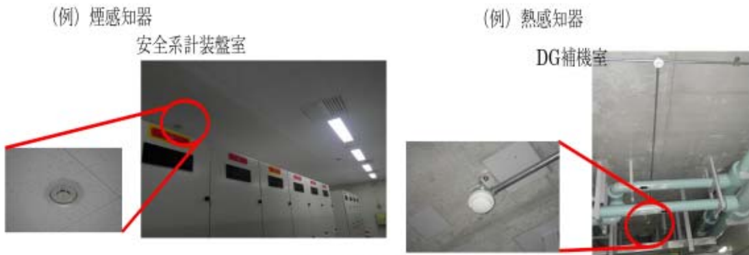
図-8 煙感知器、熱感知器設置例
