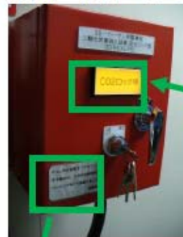
写真③ 放出ロック盤
