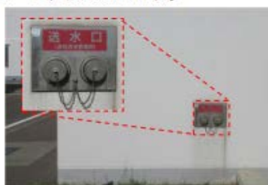
図-1 連結送水口設置状況
