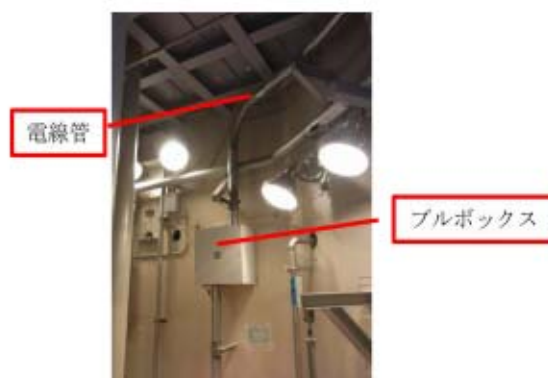
図－5 核計装電線管布設状況
