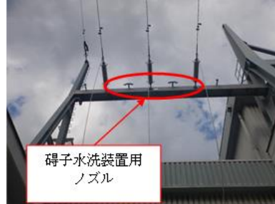
220kV 送電線（開閉所出口） 66kV 送電線（開閉所出口）
