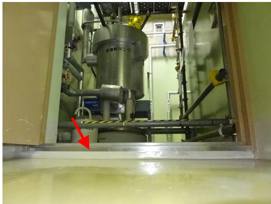
図 4-1 漏えい油の拡大の防止対策の例
