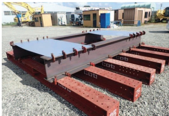
写真1 模擬屋根設置
