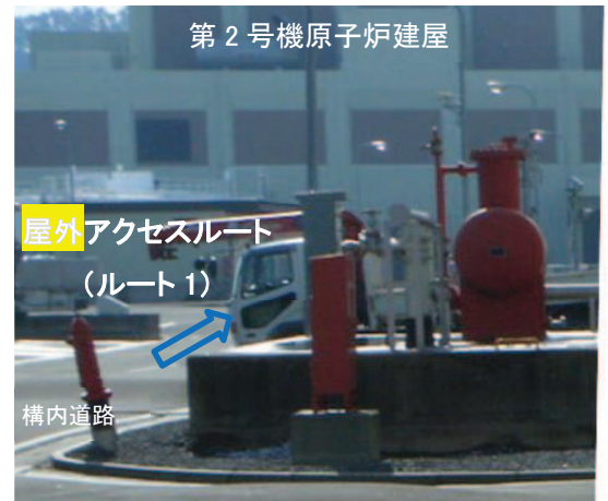
写真 C:地震後の状況【平成 23 年 3 月 12 日撮影】
