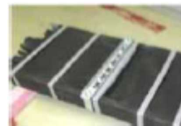
ファイアストップパの施工例
