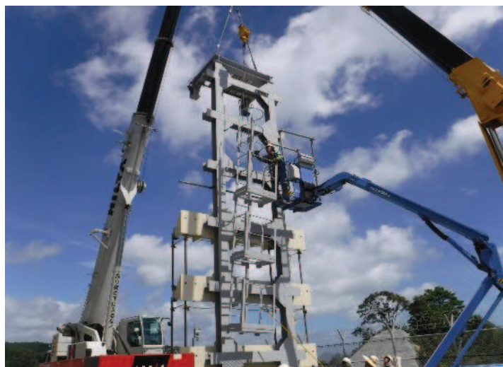
写真 4-2 吊治具の立起こし状況
