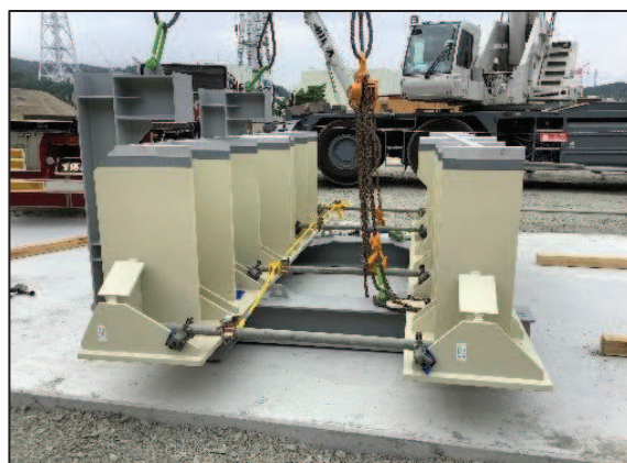
吊治具と架台の固定状況（最上段）
