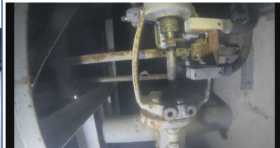
リミットスイッチ部の拡大
