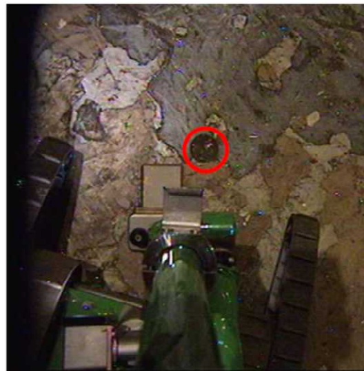
部拡大現場状況
