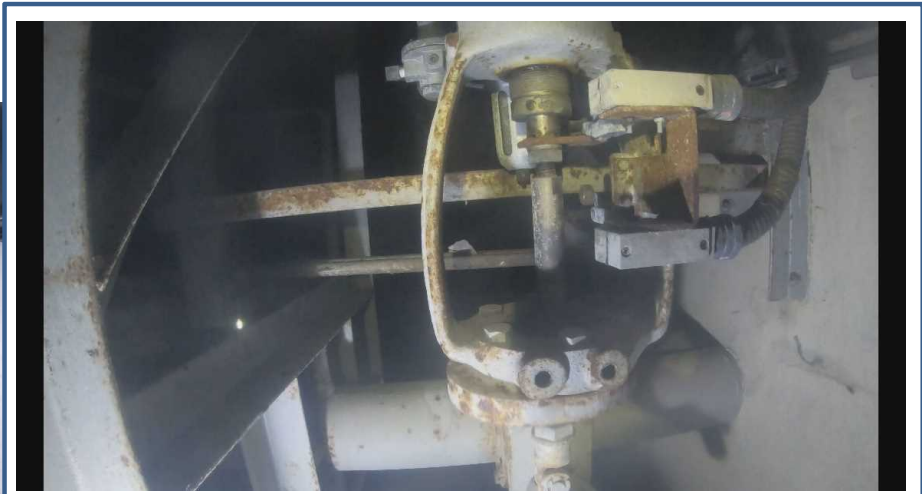
リミットスイッチ部の拡大
