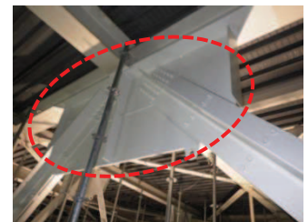
屋根トラス接合部の補強状況写真
