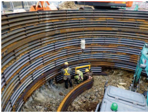
土砂部ライナープレート取付け
