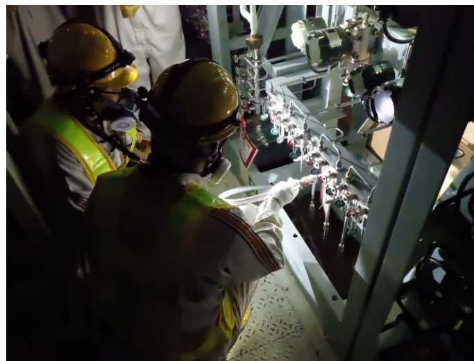
受入槽等への直接給水(遅延対策①)(各班毎に実施)
