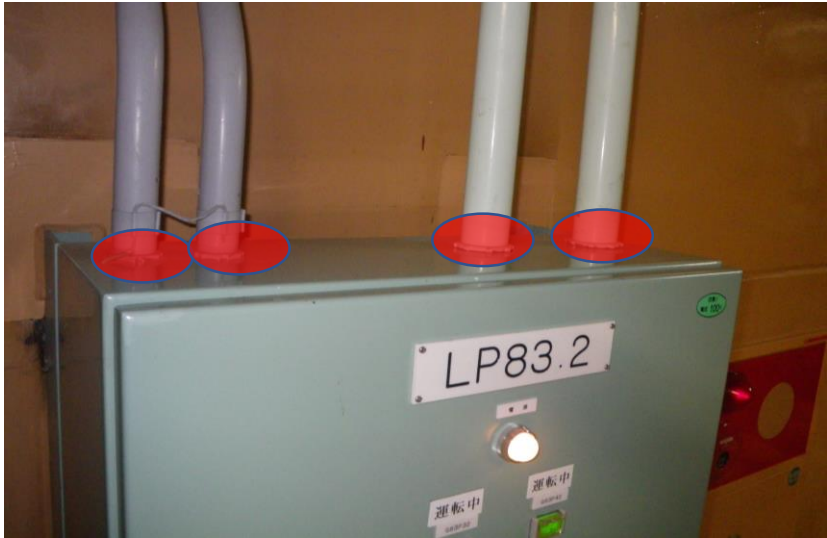
シール処置概要（電線管接続部へのシール処置の例）
