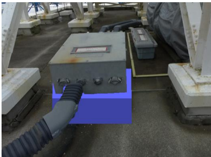
嵩上げ例（緊急電源接続盤（端子箱））
