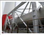
排気ダクト接続架構の補強(完了後)                      |   |   |   |   |   |    |    |    |   |   |   | 完了                                                                                                        |   |   |   |   |   |    |    |    |  |  |  |
