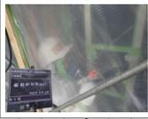
工事前の調査で既設の壁に使用されていたことが判明したアスベストの除去作業状況 |   |   |   |   |   |    |    |    |   |   |   | アスベストの除去が必要になったことから工事完了予定が令和4年1月末となった。                                                                    |   |   |   |   |   |    |    |    |  |  |  |
