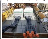
移動式電源車からの給電用ケーブルを建家間でつなぐハンドホール及び埋設管路の敷設状況 |   |   |   |   |   |    |    |    |   |   |   | 完了予定                                                                                                                       |   |   |   |   |   |    |    |    |   |   |   |                                                                                                           |   |   |   |   |   |    |    |    |  |  |  |
