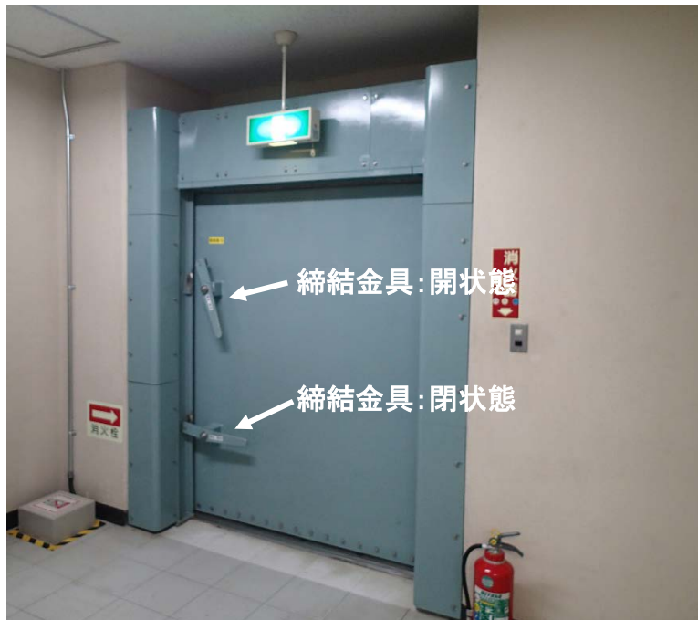
図-3 浸水防止扉 TVF-10（開状態）の耐震補強を行う箇所
