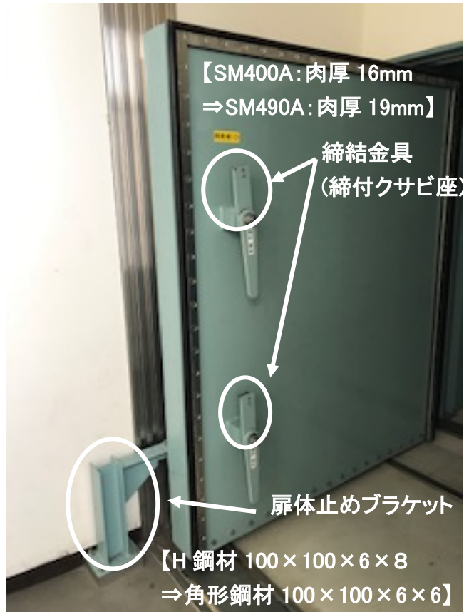
図-3 浸水防止扉 TVF-10（開状態）の耐震補強を行う箇所
