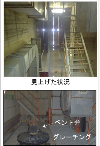
循環水管エリアの状況
